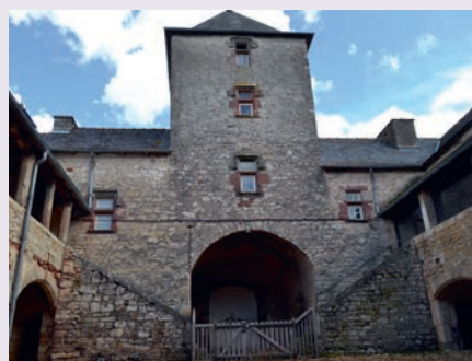
Vue de la cour intérieure
